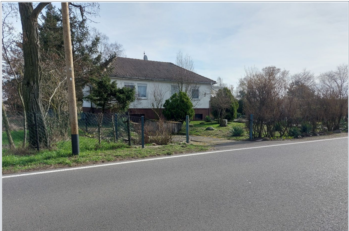
Abb. 13 Blick auf das einzelne Haus am östlichen Ende des Plangebietes.
