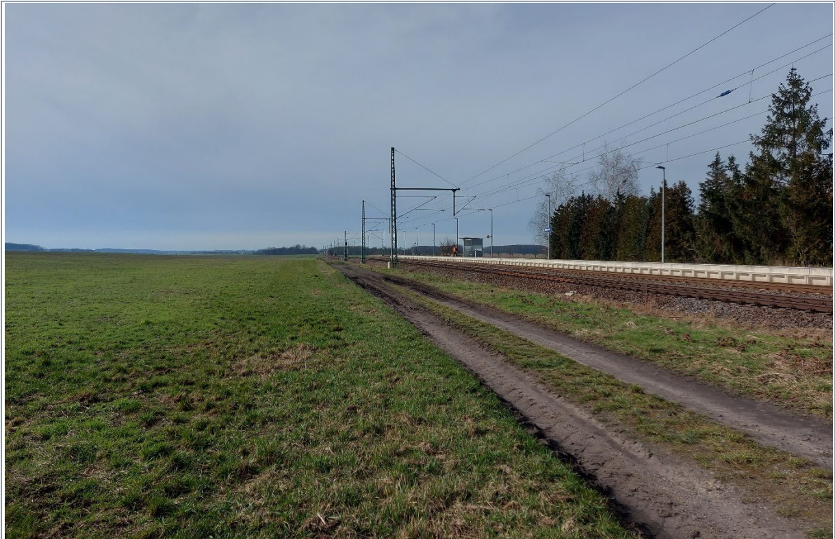
Abb. 12 Blick entlang dem nördlichen Ende des Plangebietes. Neben dem Bahndamm verläuft der unbefestigte Feldweg. Dieser weist tiefe Fahrinnen auf.
